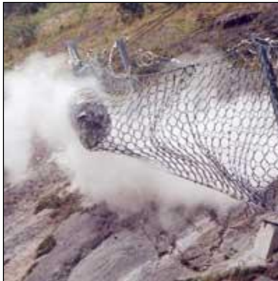
Εικόνα 28. Τυπική διάταξη συστημάτων ανάρρησης πτώσης βράχων απορρόφησης ενέργειας.
