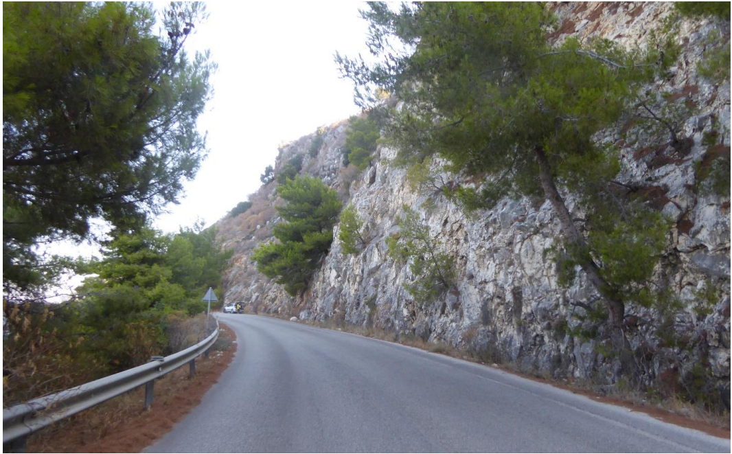
Εικόνα 9. Γενική άποψη του πρανούς (θέση λήψης από νότο, επί της επαρχιακής οδού).
